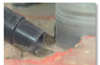
Absaugen des Bohrschlamm
