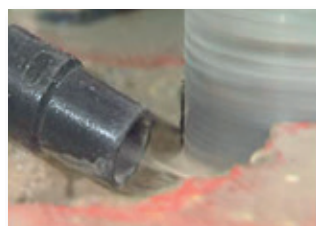
Absaugen des Bohrschlammes
