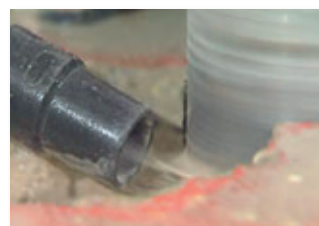
Absaugen des Bohrschlammes
